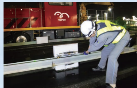
軌道の点検・調整
